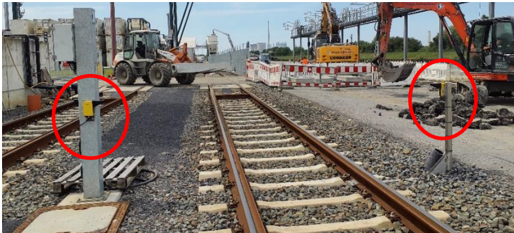
Lichtschranke Gleis 3 (4+5+6 ähnlich)
